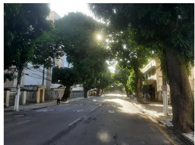
Figura 2: Vista do 2º quarteirão da Av. Nazaré, apresentando a pista asfaltada, mangueiras, postes e calçadas com pedra portuguesa.
