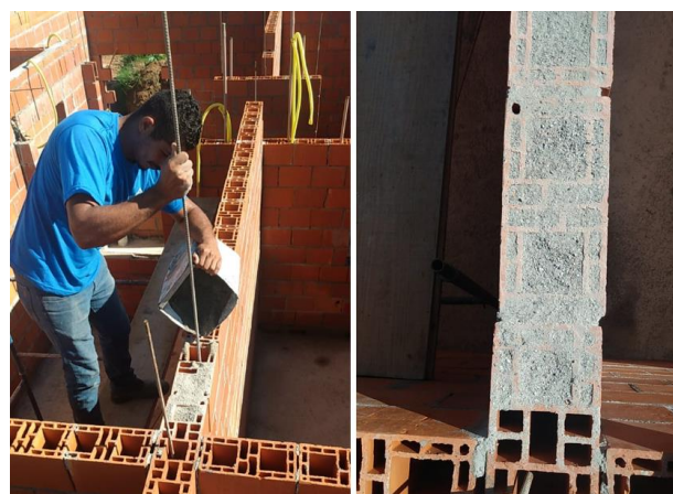
Figura 3 - Execução dos preenchimentos dos blocos com agregado reciclado.
