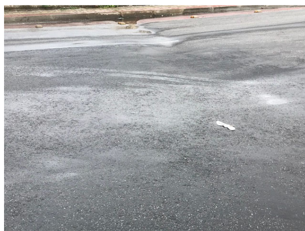
Figura 6 Vista da pista com valeta (F)
