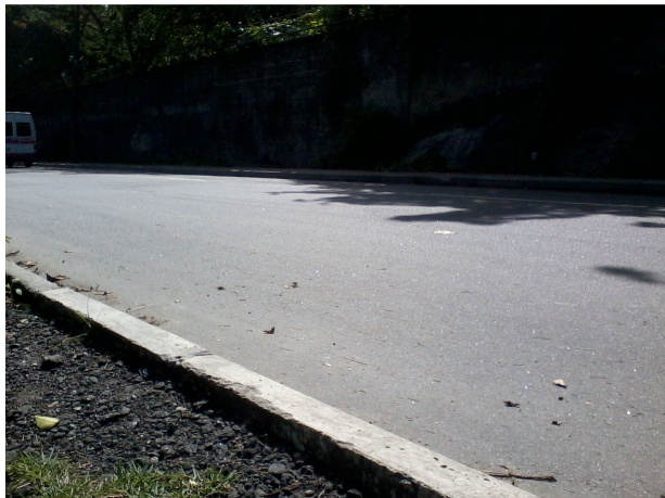
Figura 1 Vista da pista com asfáltico (A)
