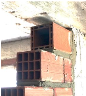
Figura 3: Bloco cerâmico de encunhamento
