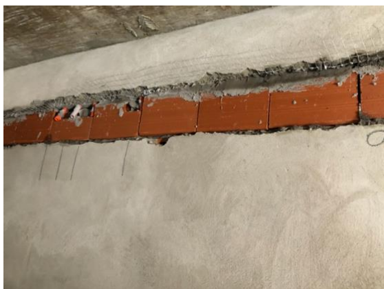
Figura 7: Alteração bloco encunhamento
