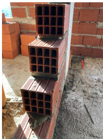
Figura 2: Bloco cerâmico utilizado
