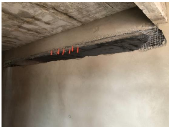
Figura 6: Remoção bloco encunhamento
